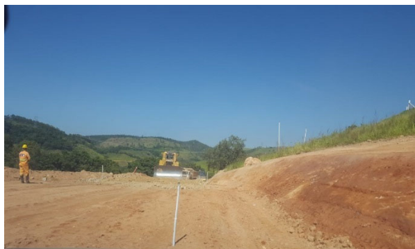
Foto 13: Construção acesso MD01 21/04/2020
