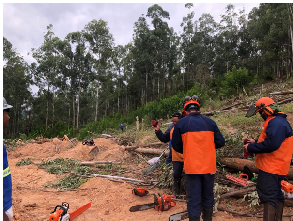
Foto 27: Acompanhamento da atividade de supressão (Data: 13/04/2020)
