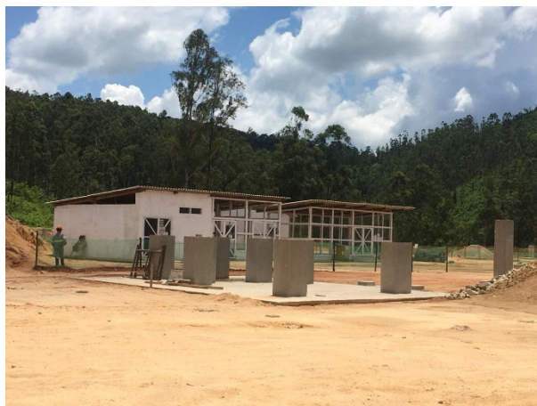
Foto 1: Avança da Construção de Estruturas no Canteiro operacional (07/01/2020)
