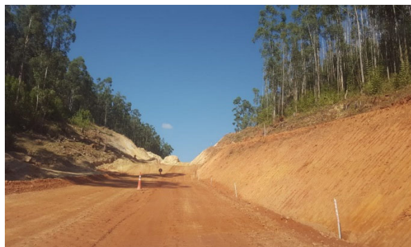
Foto 14: Construção acesso MD03 21/04/2020
