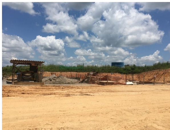
Foto 2: Avança da Construção de Estruturas no Canteiro operacional (07/01/2020)
